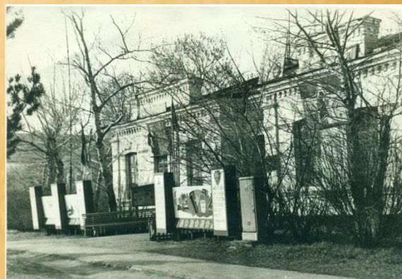
Здание дома священника, начальной школы, военного комиссариата, 1984 г.
