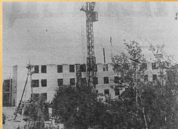
Строительство терапевтического корпуса Шербакульской ЦРБ, 1984 год
